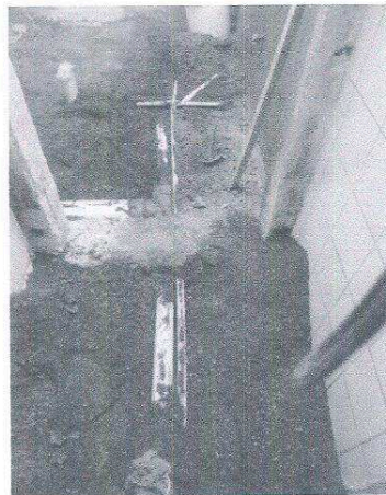
Fotos en la que se prepara el rellenando de zanjas para las tuberías de aguas servidas y agua potable en la restauración de baños en el sótano del Palacio Nacional de la Cultura
