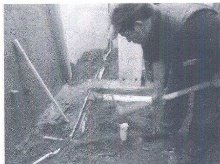
Fotos en la que se prepara el rellenando de zanjas para las tuberías de aguas servidas y agua potable en la restauración de baños en el sótano del Palacio Nacional de la Cultura
