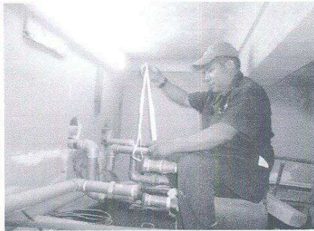
Mantenimiento preventivo de los motores que impulsan agua potable hacia los tanques elevados del Palacio Nacional de la Cultura y extracción del ripio de la azotea del Torreón Central
